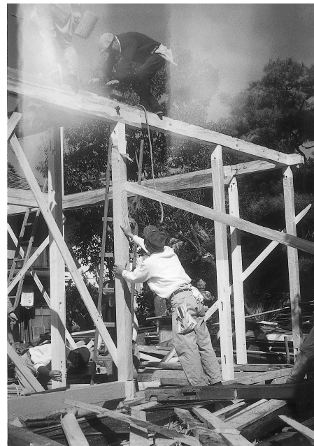
家の建て替え作業
